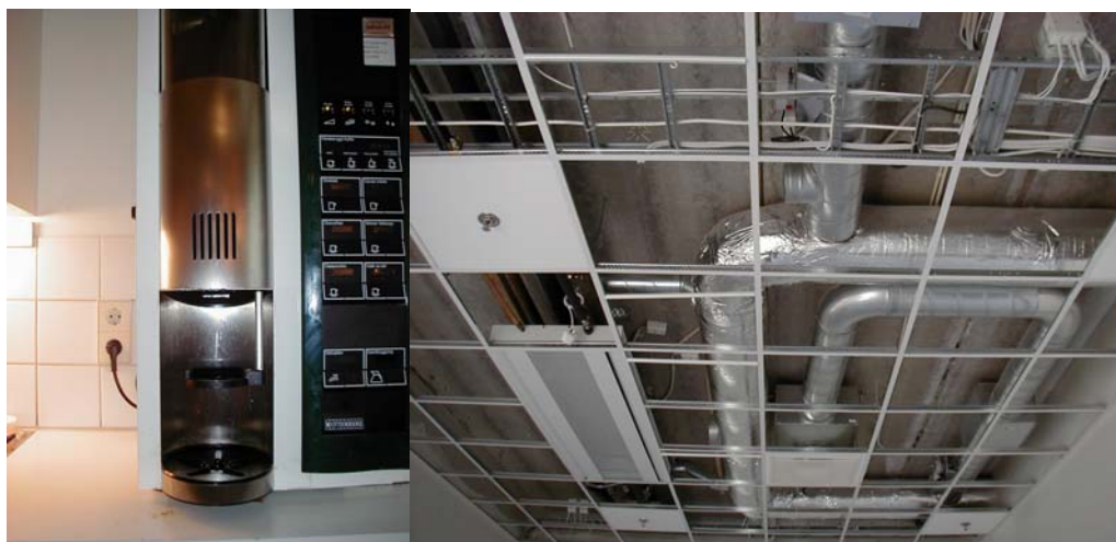
Figur 5.10. Exempel på produkter som kan vara startpunkter för vagabonderande strömmar. Kaffemaskin som är metalliskt ansluten till ett vattenrör, Skyddsjordad armatur som sitter i ett metalliskt undertak, foto Svante Wijk.
