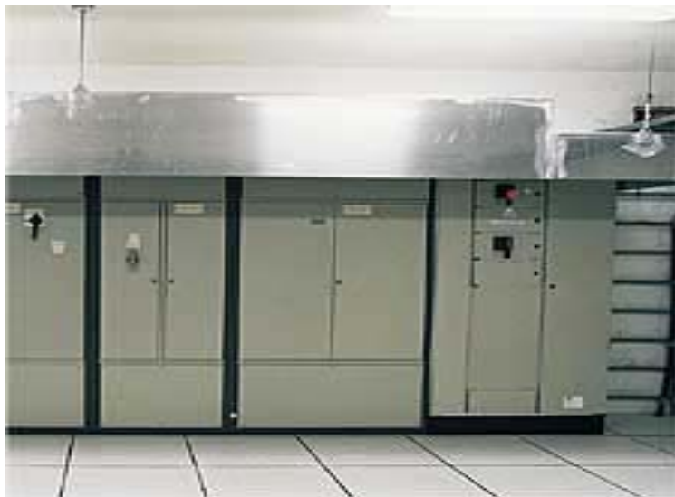
Figur 6.5. Skärmning av ställverk med en huv
