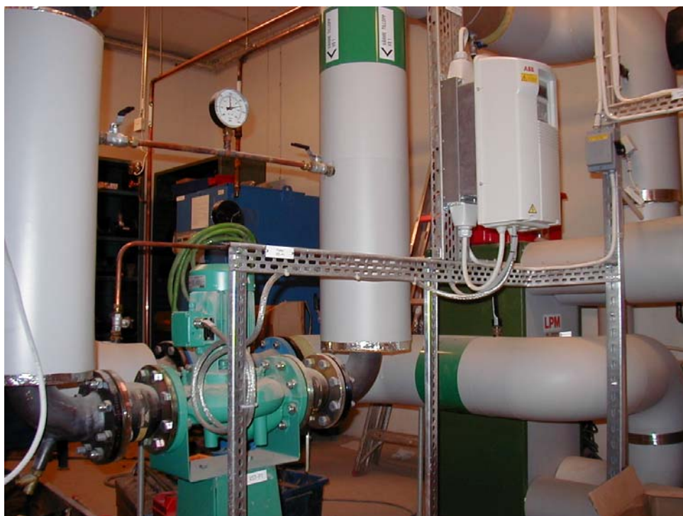
Figur 3.11. En cirkulationspump för fjärrvärme har ett skyddsjordat hölje som står i metallisk kontakt med fjärrvärmerörerna, vilket innebär en överledningspunkt för vagabonderande strömmar vid fyrledarinstallationer, foto Svante Wijk.
