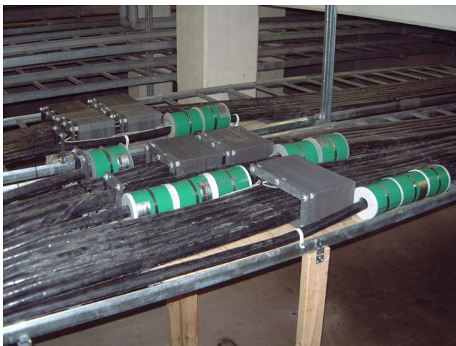
Figur 5.11. Sugtransformator kärnor installerade i en stor fastighet med många parallellkopplade ledningar, för att reducera vagabonderande strömmar i parallellkopplade ledningar, har det utvecklats speciella kärnor, som kan omsluta många kablar, foto EnviroMentor AB.
