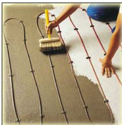
Figur 6.3. Förläggning av elvärmegolv, foto Thorin & Thorin.
