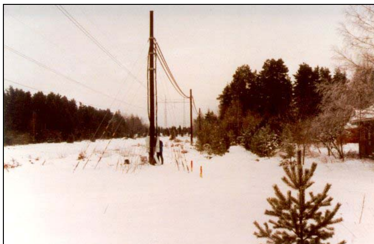
Figur 6.1 Skärmslinga som reducerar magnetfältet från den intilliggande kraftledningen, källa Svenska Kraftnät.
