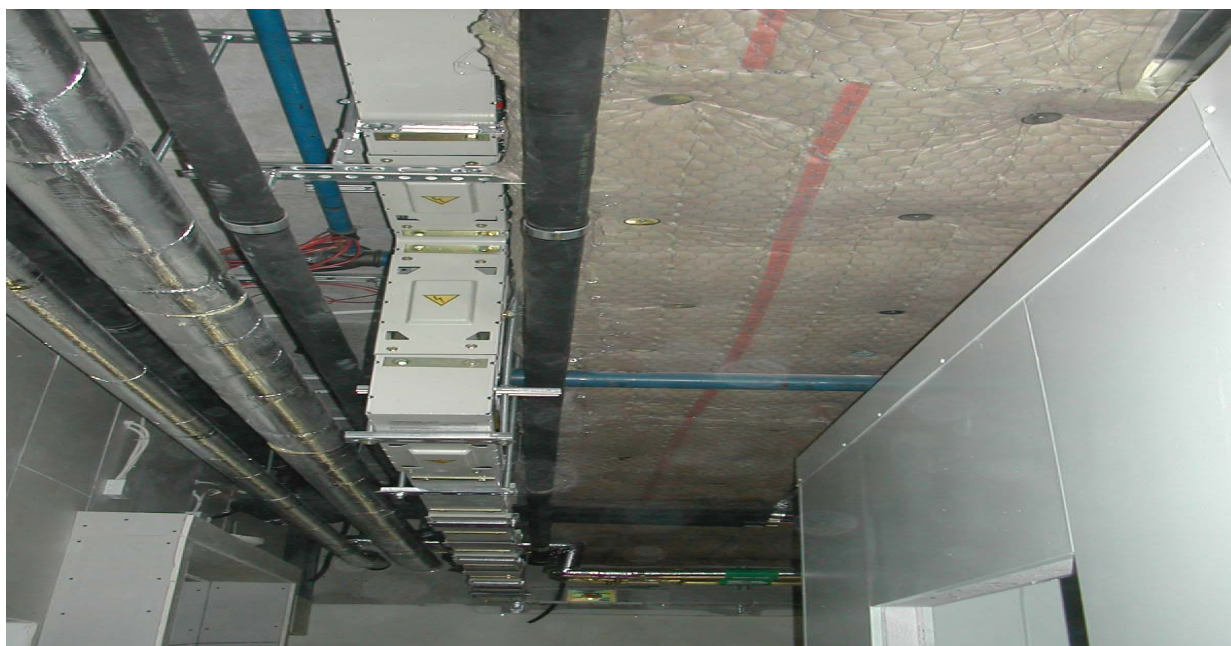
Figur 6.6. Kompaktskena för matning från ställverk på plan 1 till plan 12, källa: Schneider Electric.
