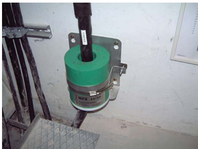
Figur 5.7. En sugtransformator-kärna monterad på en serviskabel, denna kärna är öppningsbar och kan därför monteras på kabeln utan att kabeln behöver kopplas ur, foto EnviroMentor AB.
